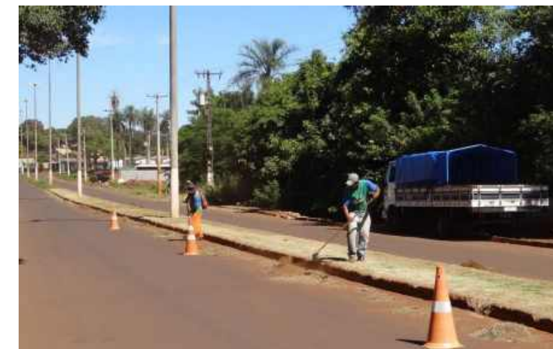
Figura 82 - Execução dos serviços de capina e raspagem em Maracaju/MS. Fonte: Deméter Engenharia Ltda.
