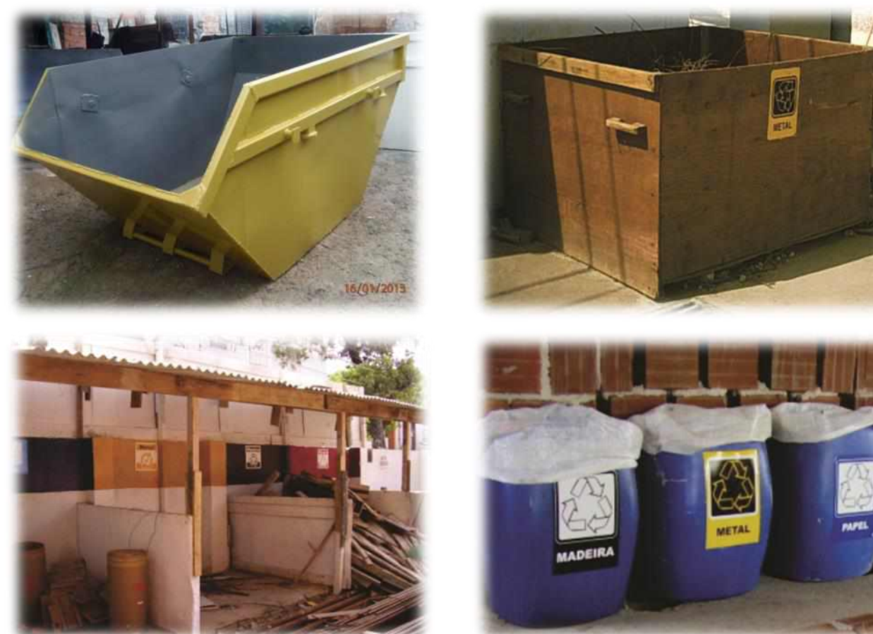
Figura 71 - Formas de acondicionamento temporário e final para Resíduos da Construção Civil em canteiros de obra Fonte: Souza (2007).
